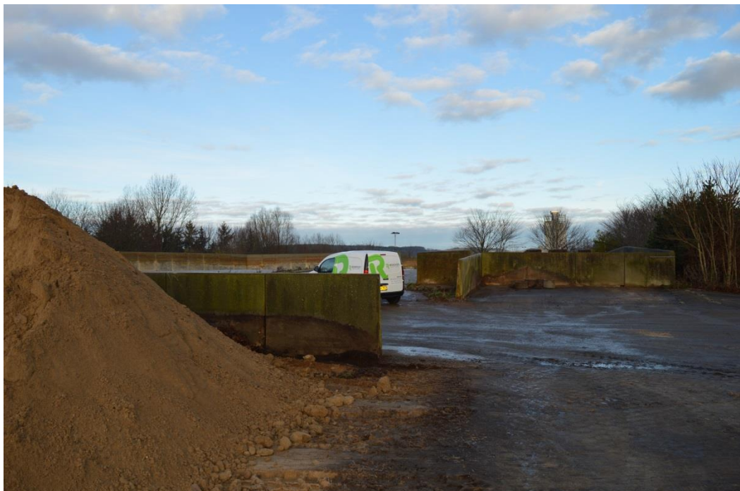
Her er et kig ind på det, der bliver selve genbrugspladsen. Belysning og etablering af mandskabsvogn påbegyndes snarest. Desuden fjernes de gamle betonelementer.
