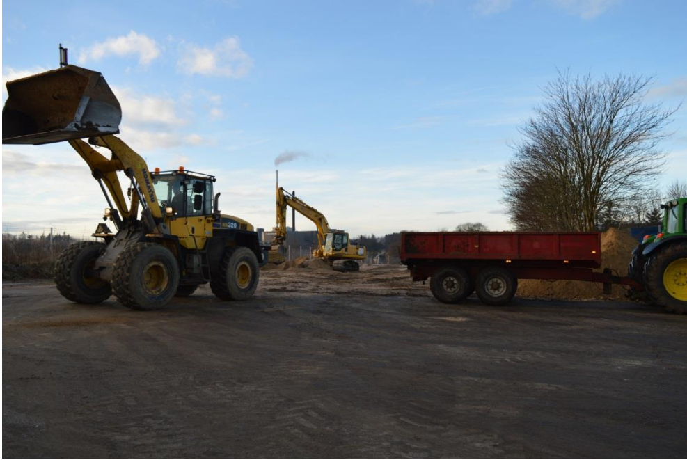
Ny genbrugsplads i Aars under opbygning. I baggrunden ses varmeværket.
